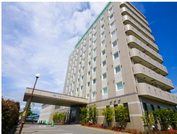
ホテルルートインいわき泉駅前/西館
